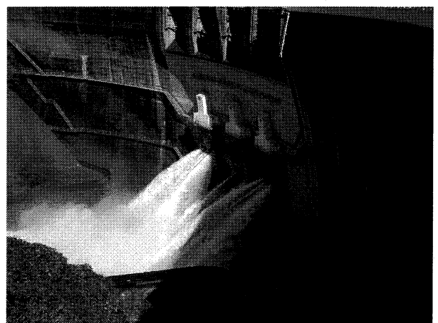
【既存のゲートからの放流状況(全開時)】
